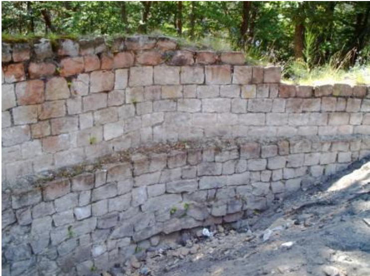
Abb. 1 : Ringmauer des Schlössel während der Ausgrabung 2003, Foto : Werner Westermann
