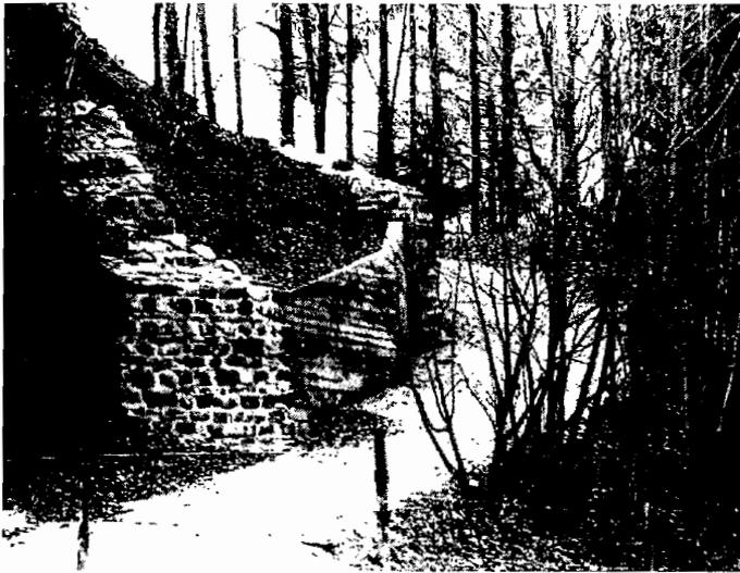
Abb. 52 Wollhusen, Äußere Burg/Wiggern. Die auf ihren Resten neu aufgebauten Mauern M3, M7 und M8, von O. Die Lücke zwischen den zwei Mauerstücken wurde mit einer Betonmauer geschlossen.
