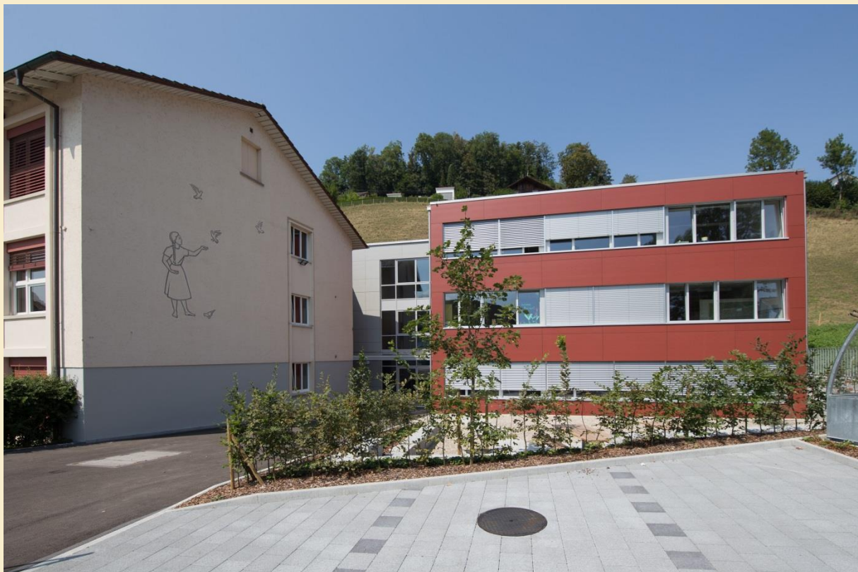
Der neu erstellte Anbau (Bild: Baumeler Partner AG)
